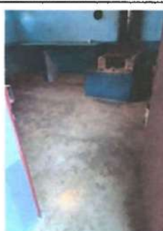
Foto 2: Sustrucción de piso de acabado liso, por piso cerámico antideslizante en área de cocina.
