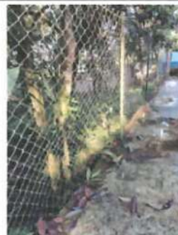
Foto 4: Sustrucción malla de acero galvanizado en perímetro del establecimiento, con instalación fija y tensa, anclajes metálicos en intervalos regulares.
