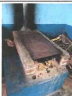
Foto 5: Sustrucción de estufa rural con chimenea, plancha y accesorios.
