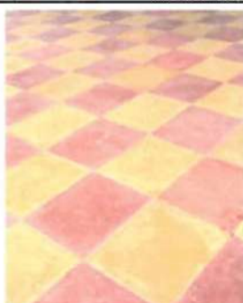
Foto 1: Sustrucción de piso, por piso cerámico en áreas de aulas, dirección, bodega y corredor.
